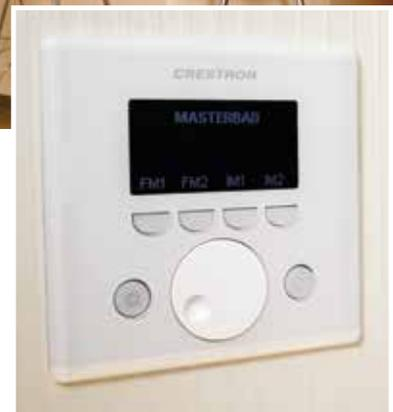
Mediensteuerung von Crestron. Das bedeutet, dass man für die klassischen Gewerke wie Licht, Verschattung & Co. die typische KNX-Verkabelung vorfindet, also das grüne Buskabel zu Aktoren und Sensoren. Über eine Schnittstelle kommuniziert die leistungsfähige Steuerungstechnik von Crestron mit dem KNX-Bus und kann so alle Funktionen ebenfalls steuern.
